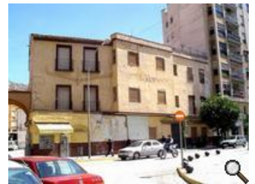
Lledó confía en que las obras del Hotel Alicante se puedan realizar al tiempo que las del Conservatorio.
